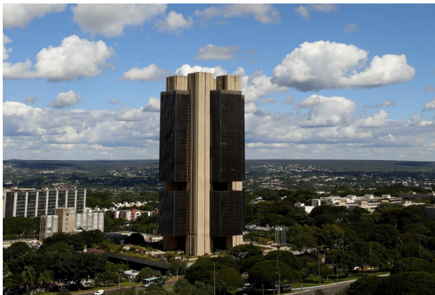
Edifício-sede do Banco Central, em Brasília. Crédito: Raphael Ribeiro/BCB
